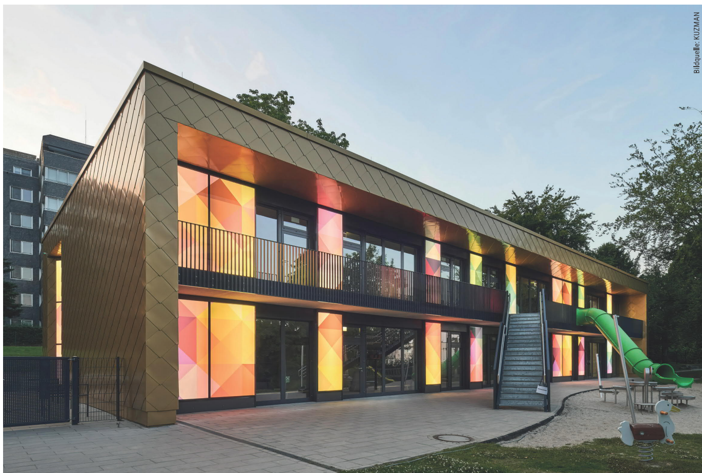
Die kombinierte Fassadenlösung mit Wandrauten und Lichtelementen ist nicht nur funktional gelungen. Der langgezogene Baukörper zeigt bei Licht und auch bei Dunkelheit seine besondere Wirkung.
