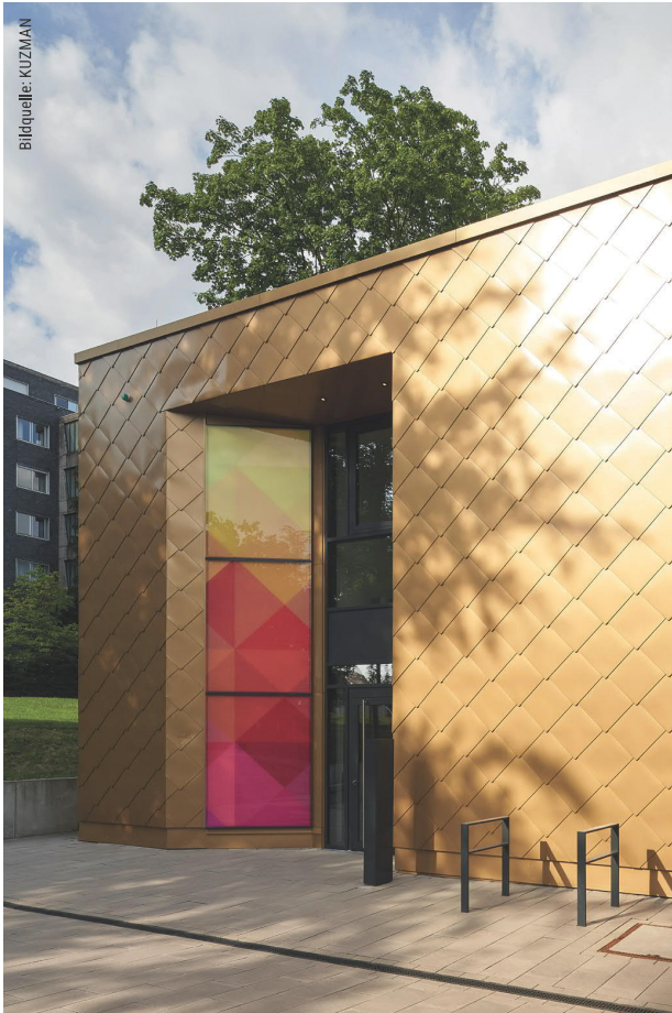
Als Außenbekleidung für die Kita wählten die mit der Planung beauftragten BFT-Architekten aus Aachen farbeschichtete Aluminium-Wandrauten im Farbton „Mayagold“.
